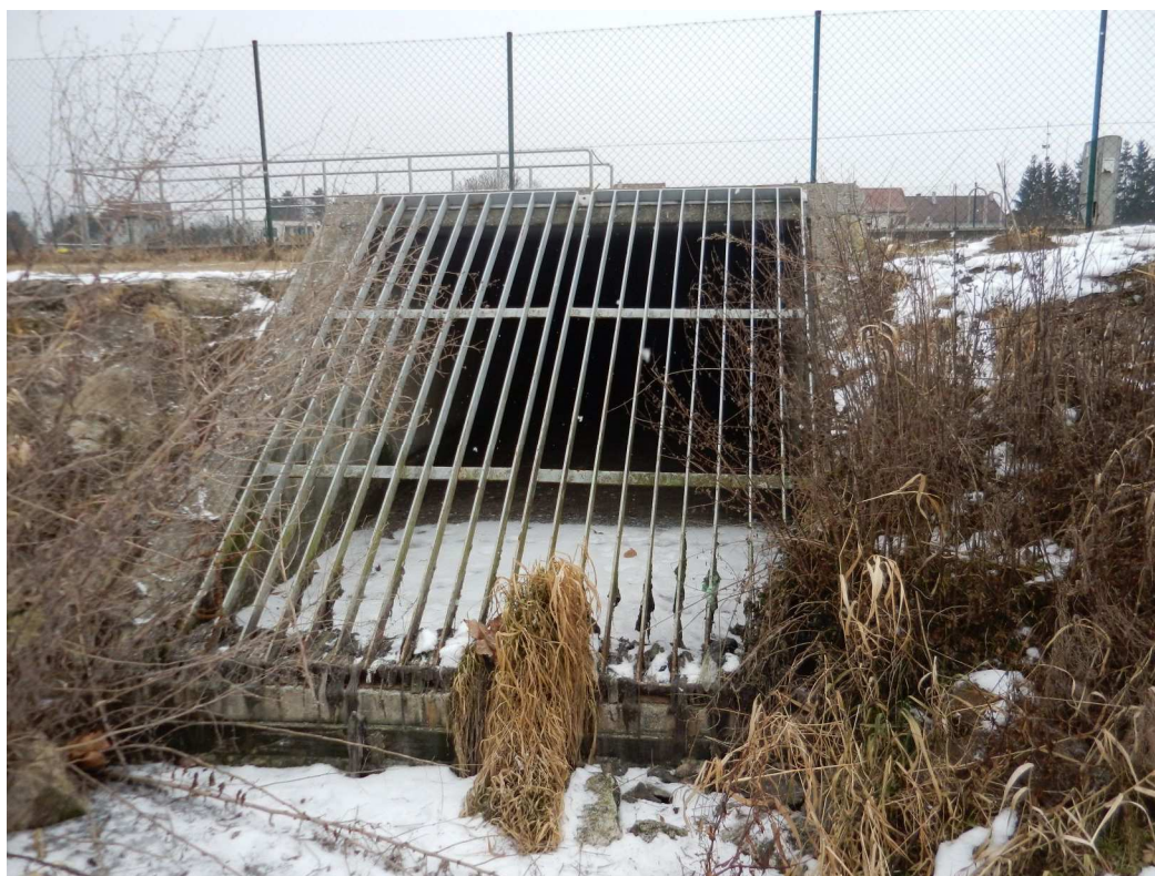
Výust' V07 – Vyústění bezpečnostního kanálu z ČS 1 do Mojeny - LB
