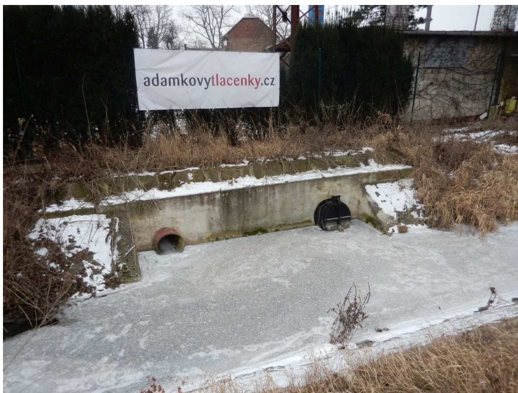
Výust V20 a V21– Vyústění potrubí z ČS 3 do Hájské příkopy - LB
