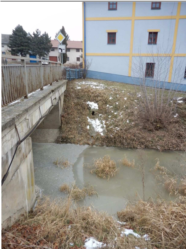
Výúst V11– Vyústění dešťové kanalizace do Mojeny - LB
