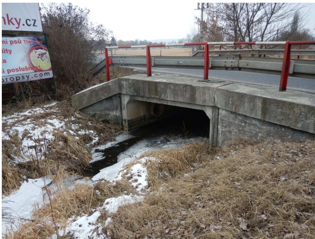
Výust V19– Vyústění dešťové kanalizace do Hájské příkopy, pod silničním postem- LB
