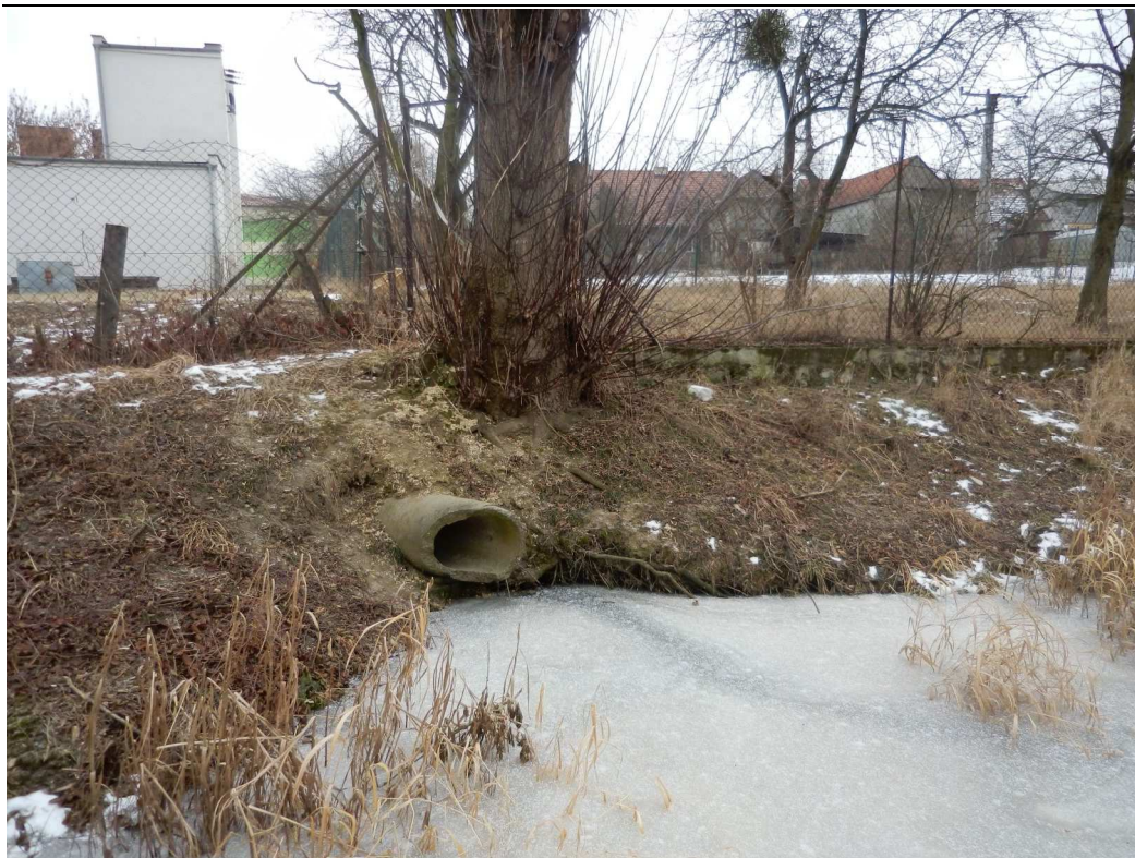
Výúst V17– Vyústění dešťové kanalizace do Mojeny - LB
