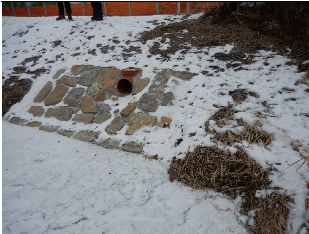
Výust' V09 – Vyústění dešťové kanalizace do Mojeny - LB
